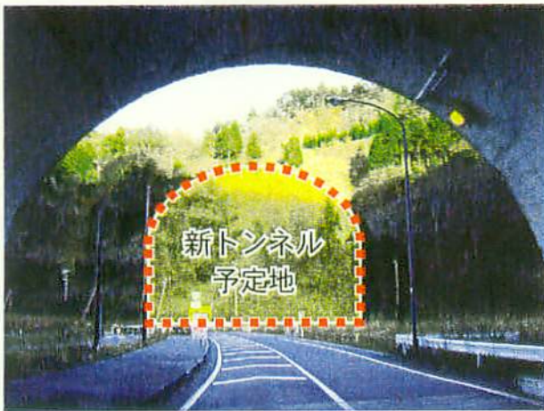
矢代トンネルより掘削予定地を望む
