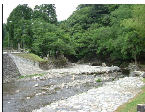
鵜の瀬周辺の景観に配慮した事例
