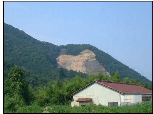
写真一山肌が削られた山地
