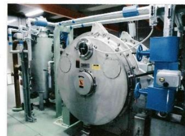
⑧汚泥機械棟内脱水設備
