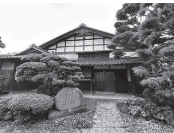
修繕を実施する山川登美子記念館
