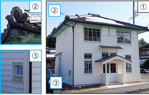
【写真】改修された旧中名田郵便局 ①レトロな雰囲気を残す外観②郵便マークがついた鬼瓦③夜間受付窓口に使われていた窓
