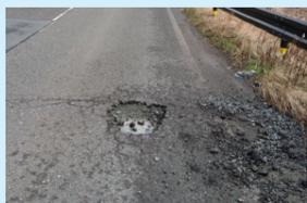
除雪作業などでもろくなり、損傷した道路
