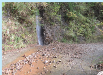
▲雨による土砂の流出で車が通れなくなった林道（本保）
