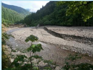
▲流出した土砂で砂防堤が埋まると、洪水や土石流の要因に（上根来）
