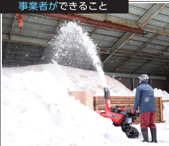
貯蔵庫を雪で覆い、雪室を製作している様子（上根来）
