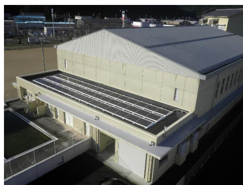
図. 3 - 1 小浜小学校太陽光発電設備
