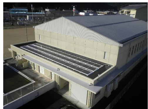
図. 3 - 1 小浜小学校太陽光発電設備
