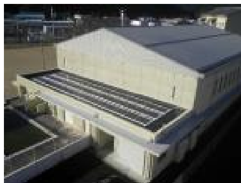
図. 3 - 1 小浜小学校太陽光発電設備
