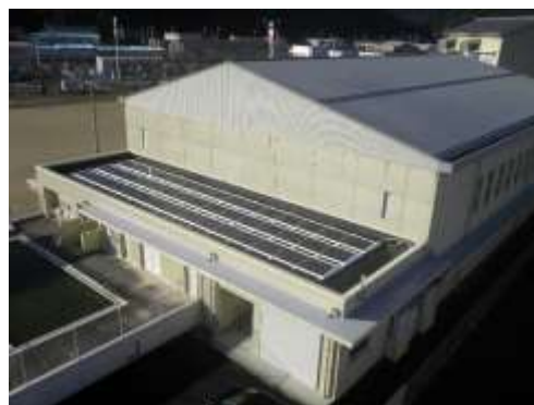
図. 3 - 1 小浜小学校太陽光発電設備
