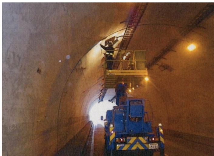
近接目視により行うことを基本とする(写真参照)
