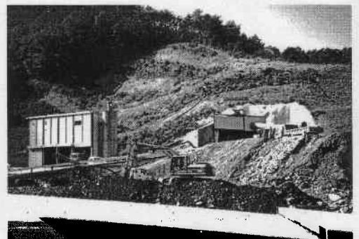
(仮称) 近畿自動車道敦賀線 飯盛トンネル付近
