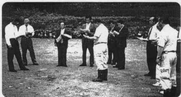
一般廃棄物最終処分場
