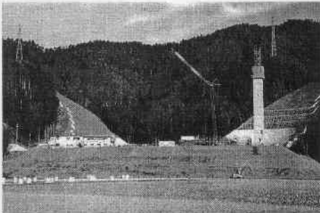
クリーンセンター建設工事
