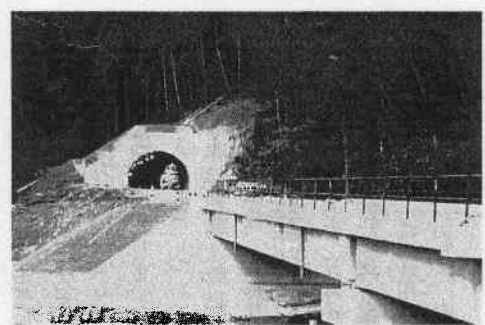
若狭西街道（神宮寺橋付近）
