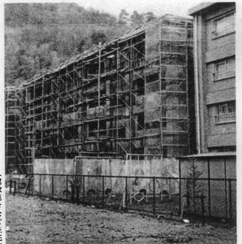
（建設進む公営住宅）
