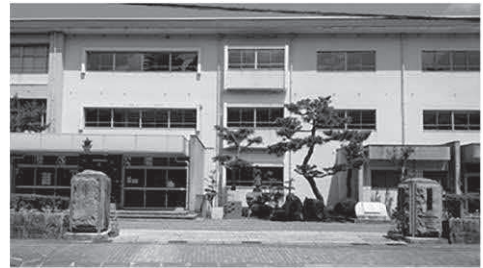
解体工事を行う旧遠敷小学校旧校舎
