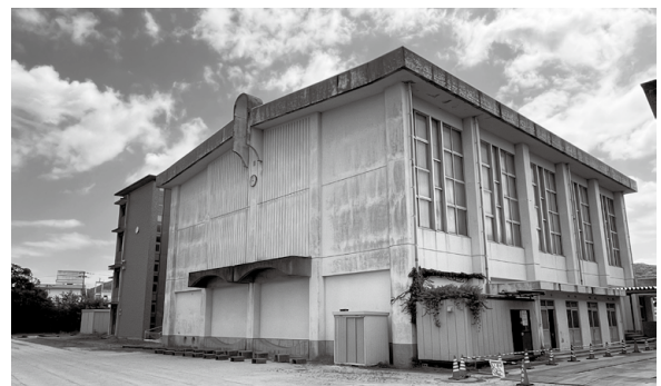
改修する小浜中学校第2体育館
