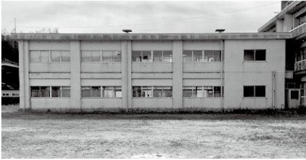
新たにふれあいスクールとなる旧遠敷小学校の新館
