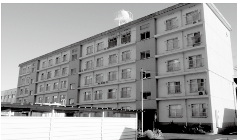
後瀬団地5号棟(後瀬町)
