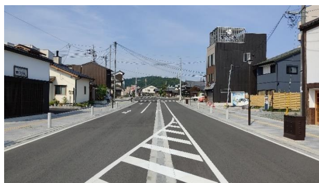
【R4.3に完成した小浜縦貫線（市道泉町線）】
