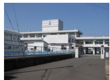
津波避難ビル指定の例 (小浜水産高校)
