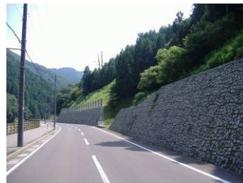
景観に配慮して整備した法面 (忠野)
