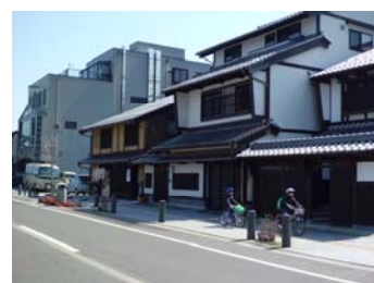
まちづくり協定に基づく良好な町並みの形成(住吉・酒井)
