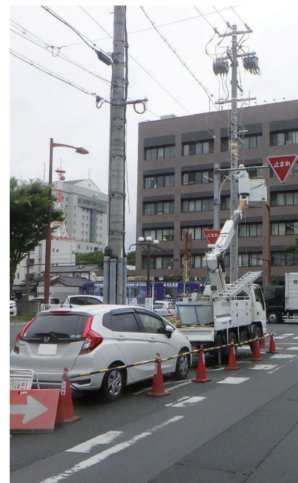
伝送路設備工事のイメージ
