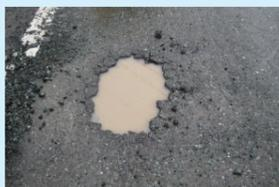
舗装がはがれ、水たまりと損傷した路面
