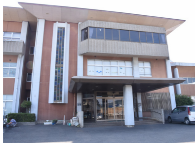
建て替え予定の健康管理センター。新施設では健康増進の機能集約で全世代をサポート
