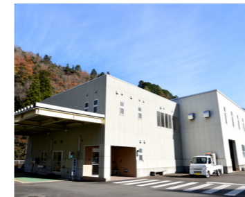
▲不燃ごみの処理施設と、最終処分場からなる「リサイクルプラザ」
