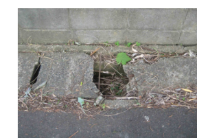
ひび割れ、一部が欠けた側溝のふた
