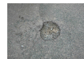
直径約20センチのくぼみができたアスファルト
