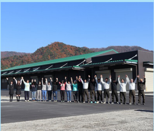
投資された資金の一部が充てられた (株)若狭の恵の乾燥調整施設・精米所
