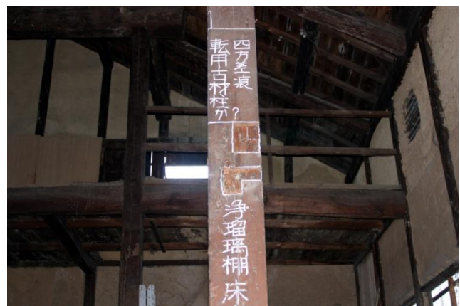
軸組みの良好な痕跡
