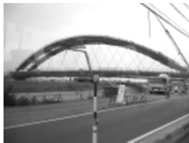
平成18年度開通予定の 「(仮称)水取大橋」
