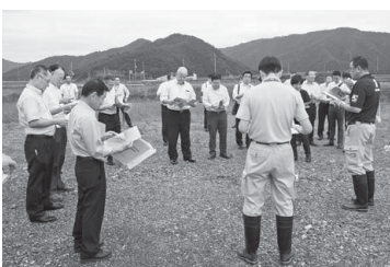
小浜美郷小学校建設現場
