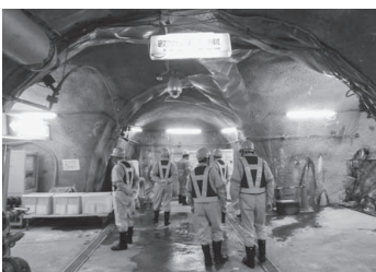
地下坑道にて
