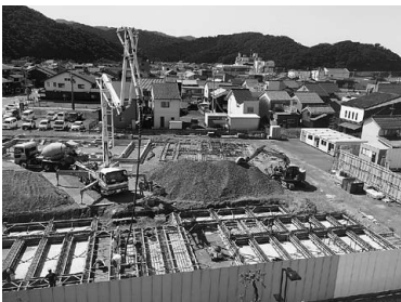
まちの駅の建設が進む
