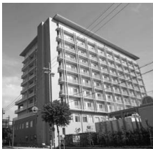
小浜病院本館
