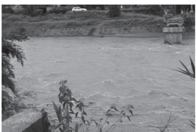
【崩落した飛川橋（口名田）】
