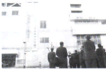
つばき回廊の現地視察をする委員会。ここでは多数の外壁の傷みが確認された。
