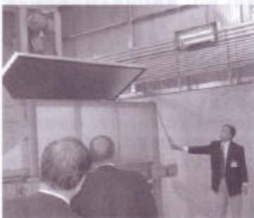
生ごみ投入口、畜排堆肥センター
