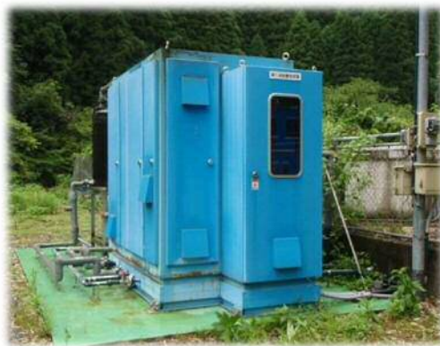
膜ろ過設備（下根来簡水）
