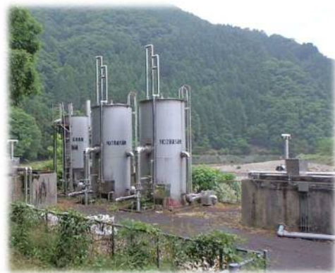
急速ろ過設備（中名田簡水）
