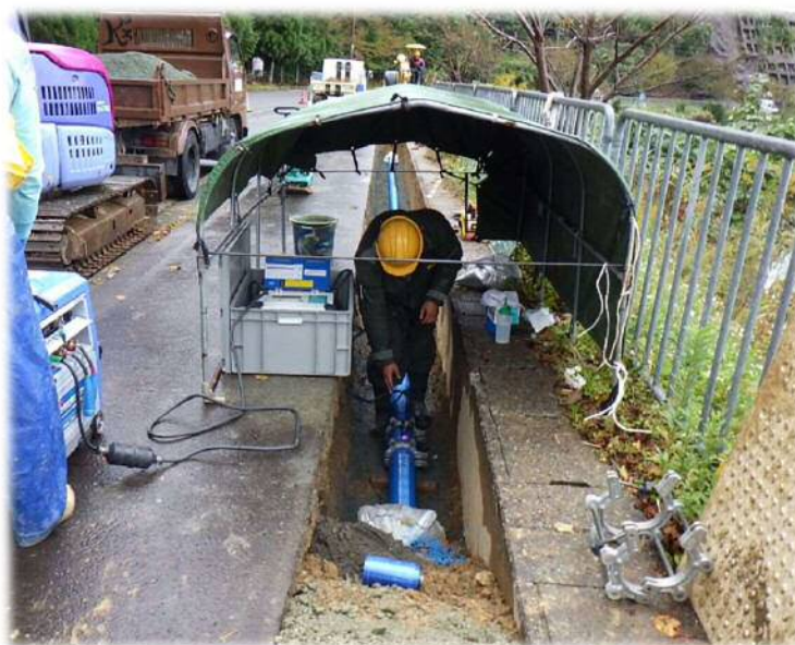
老朽管更新工事の様子
