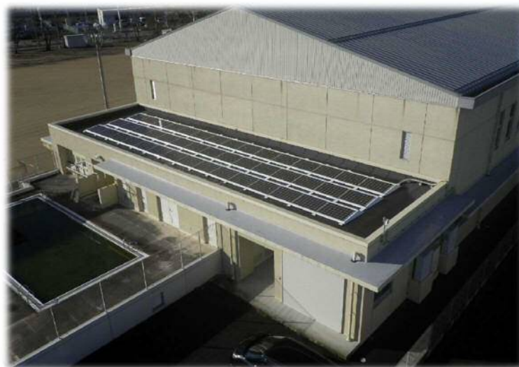
太陽光発電設置例（小浜小学校）
