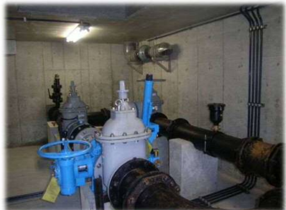
緊急遮断弁（遠敷配水池）
