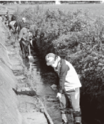
水路の泥上げ作業の様子（高塚）
