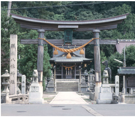
▲鳥居は高さ6.4m、柱の直径48.25cmで、左右の柱で木目の巻き方が異なる
