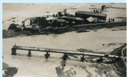
昭和28年の台風13号により流失した、当時の湯岡橋の様子
