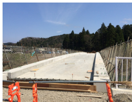
平成27年4月10日 復旧中の飛川橋
