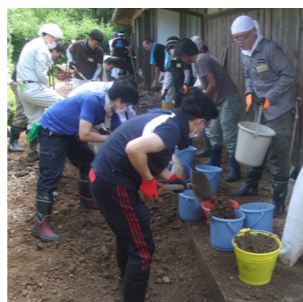
加茂区での災害復旧作業
