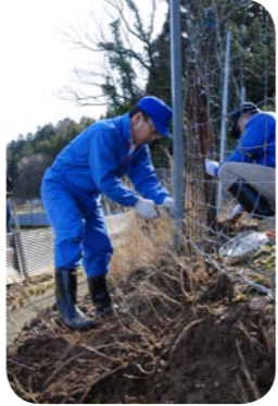
鳥獣害対策として恒久金網柵を設置
