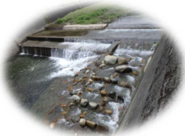
河川魚道の整備
