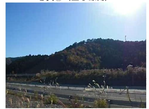
写真② (上り線側)
