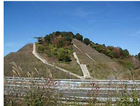
写真① (下り線側)
