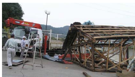
■ 倒壊家屋の解体
