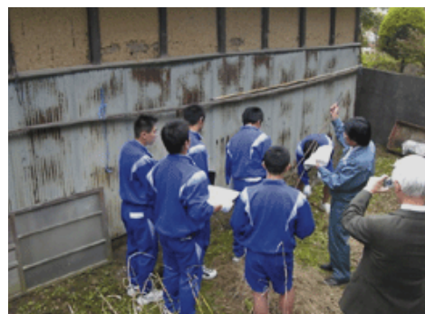
■ 松島中学校での耐震診断の実習の様子
