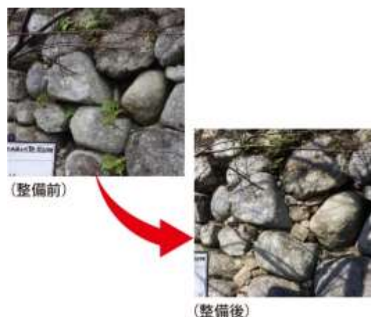
図 5-14 間詰め整備事例 [史跡松坂城跡(三重県松阪市)]
