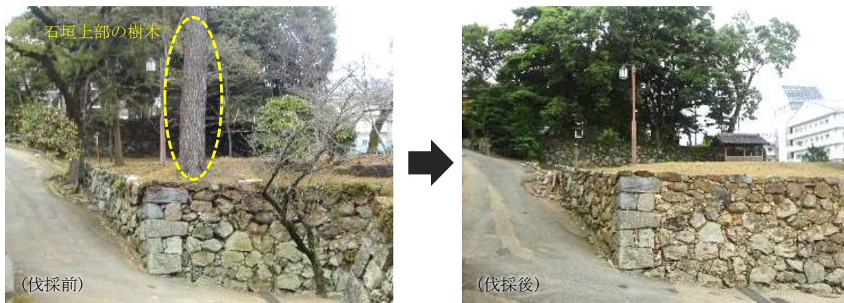
図 5-12 石垣周辺樹木の伐採事例 [史跡松坂城跡(三重県松阪市)]
