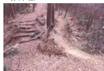
土橋(両側は豎堀)
