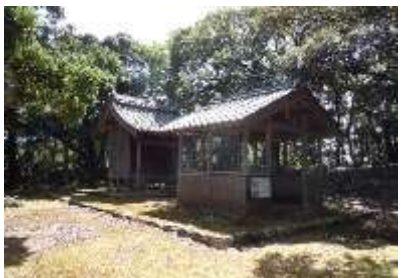
愛宕神社本殿・拝殿
