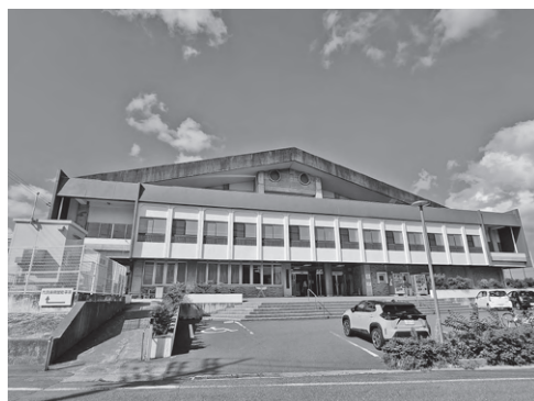
空調設備を設置する小浜市民体育館
